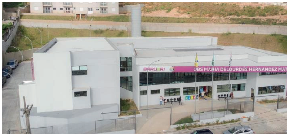
Figura 7. Prédio da UBS Maria de Lourdes Hernandez Matos. Barueri/SP. A UBS possui quatro pisos e uma infraestrutur completa para atender a população.
